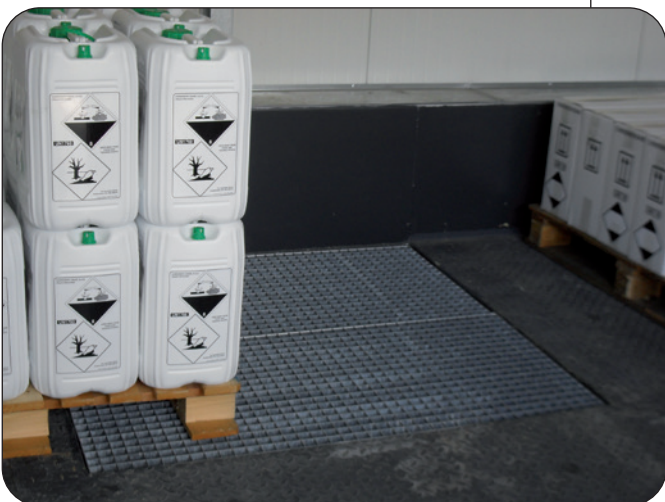
Geeignete Lagerfläche mit Pumpensumpf
